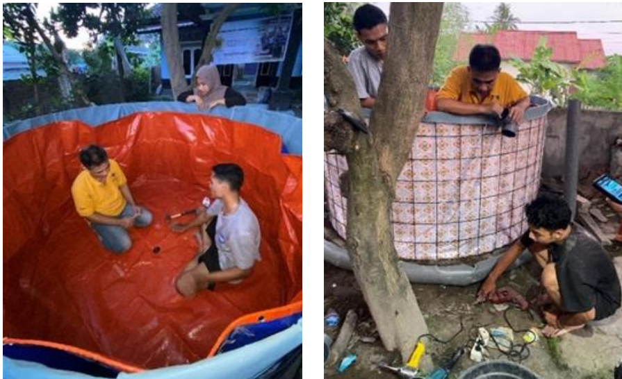
Gambar 2. Pemasangan Terpal dan Pipa
