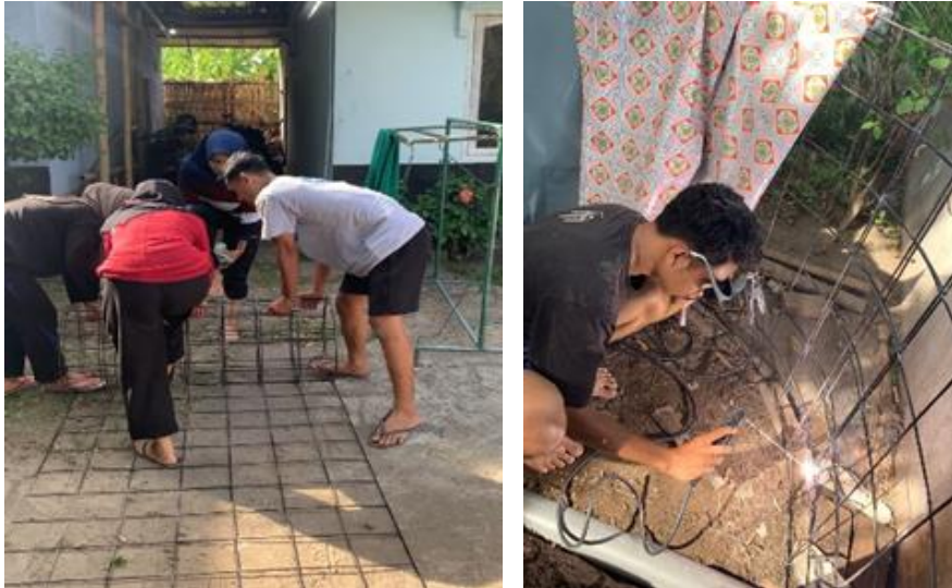
Gambar 1. Pembuatan Rangka Kolam
