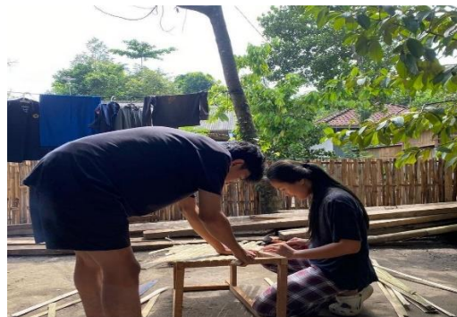
Gambar 1.5 Pemasangan bambu pada kerangka
