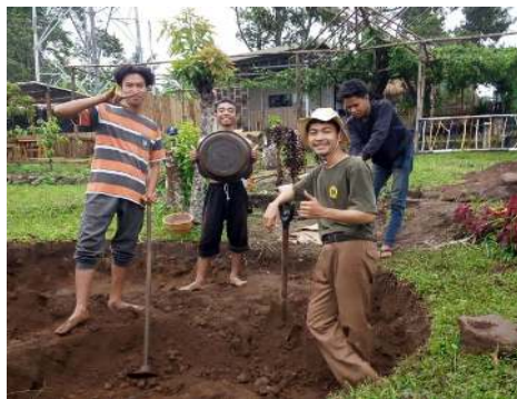
Gambar 1.2 Penggalan tanah di lokasi rest area
