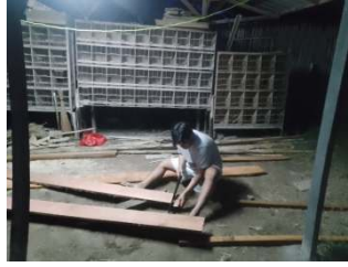
Gambar 1.13 Pemotongan papan
