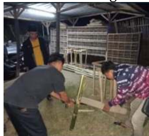
Gambar 1.7 Pematangan bambu yang akan dipasang pada kerangka tempat sampah
