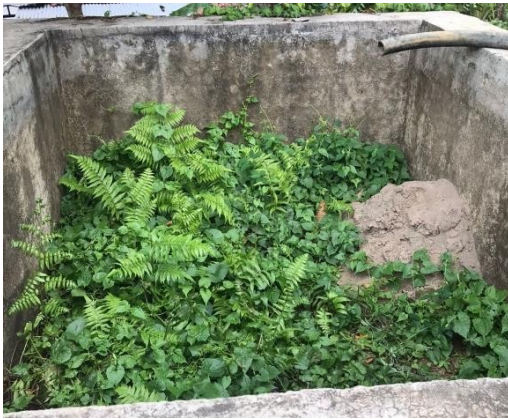
Gambar 1.3 Kondisi Bak Saat Tidak Terpakai
