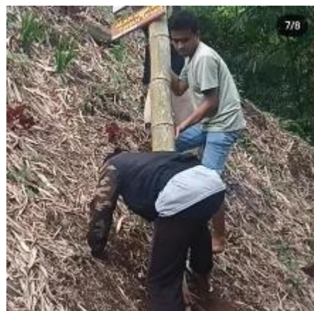
Gambar 6 :Proses pemasangan plang
