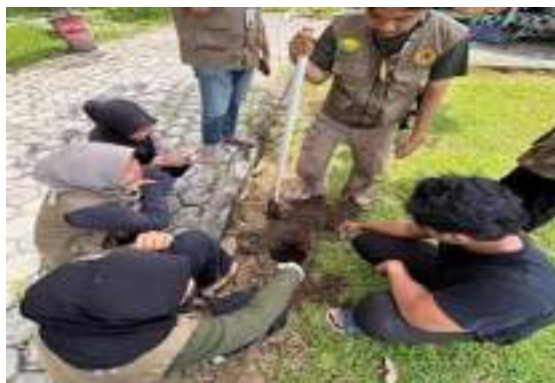
Gambar 2. Persiapan Pengaliran Lubang Biopori
