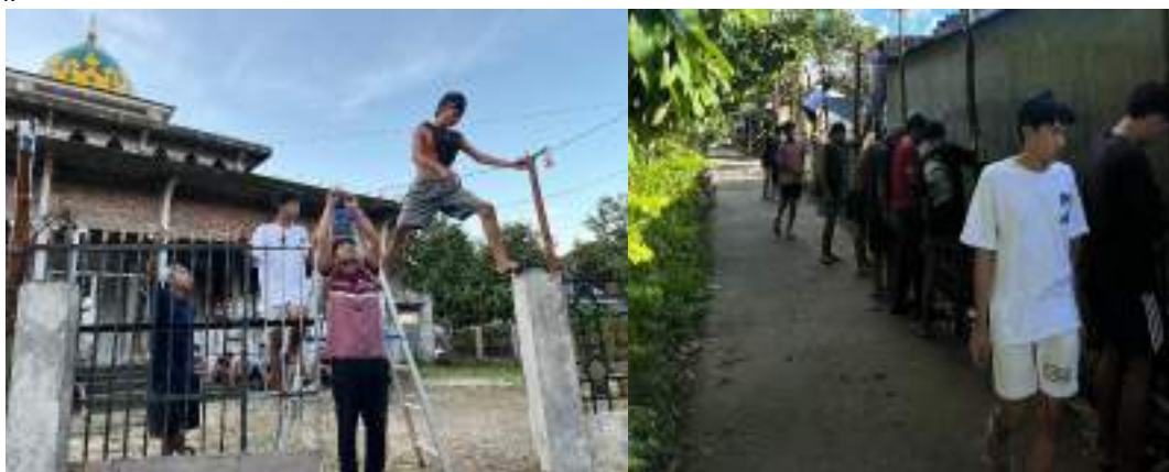
Gambar 2. Pemasangan Lampu Penerangan di sekitar masjid Sengaran
