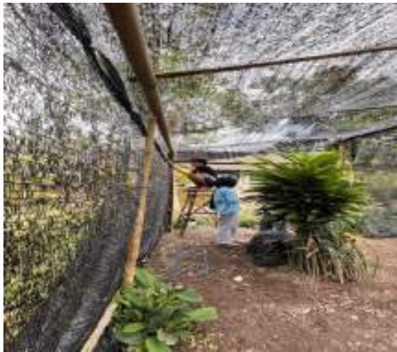
Gambar 3: Pemasangan paranet baru pada greenhouse setelah paranet lama mengalami kerusakan
