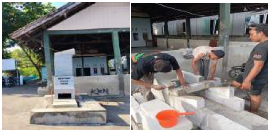
Gambar 3. Pembuatan Incinerator
