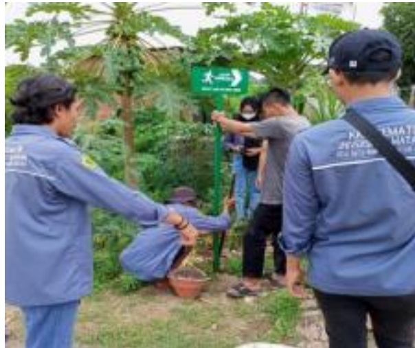
Gambar 1.3 Pemasangan plang rambu-rambu jalur evakuasi
