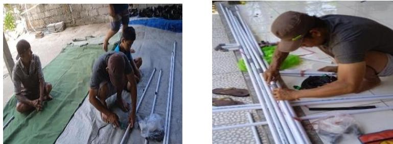
Gambar 8. Pembuatan lubang pipa dan pemasangan emitter tetes.
