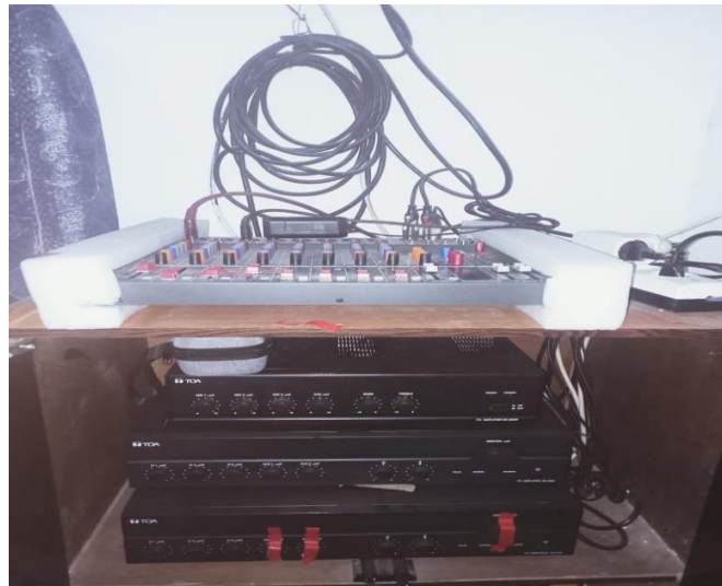
Gambar 5 perangkat sound system secara keseluruhan setelah ditambahkan amplifier dan mixer baru
