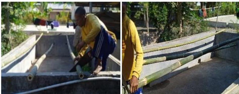
Gambar 9. Pembuatan rangka bertingkat
