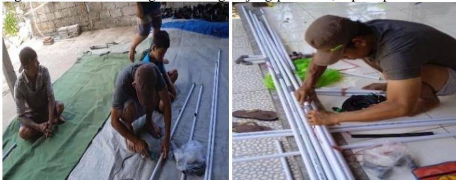
Gambar 8. Pembuatan lubang pipa dan pemasangan emiter tetes.
